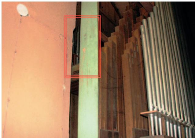
Fot. 32. Piszczałki pedału (w czerwonym prostokącie widoczne piszczałki IV wiatrownicy stojącej nad miechem)
