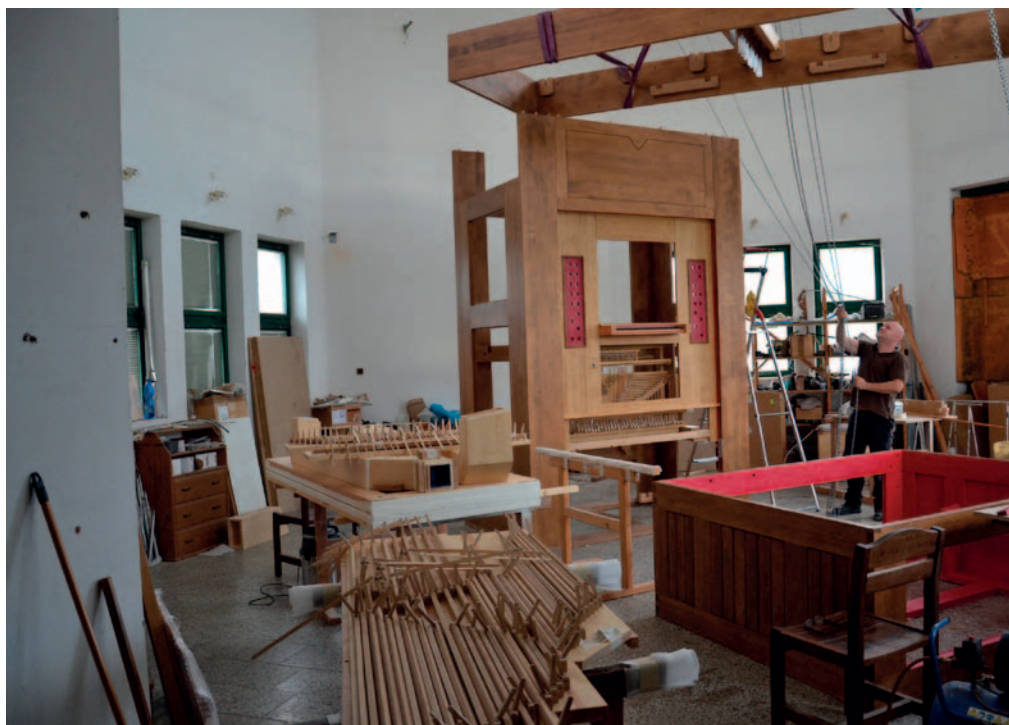
Stavba v dílně
